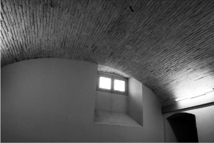
*Foto 5. Villa Redenta - Piano terra. Ambiente di collegamento tra il lato sud e la torre nord, con volta a mezza botte in laterizio.*
