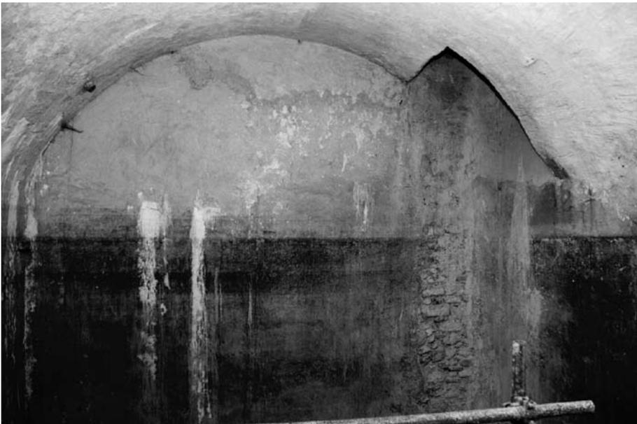
*Foto 2. Lato sud della Villa - Seminterrato. Cisterna con volta a botte e apertura per il prelievo meccanico dell'acqua.*
