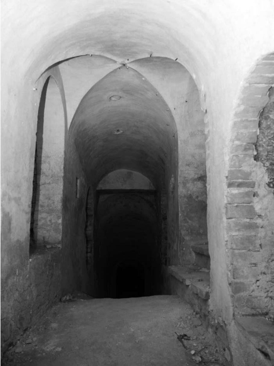
**Foto 4.** *Villa Redenta - Seminterrato. Ambiente connesso alla torre sud con volta a botte, introdotta da una crociera.*
